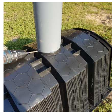
10. Vyvrtajte otvor do hrebeňa.
