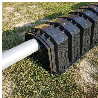
7. Skontrolujte pripojenie.
